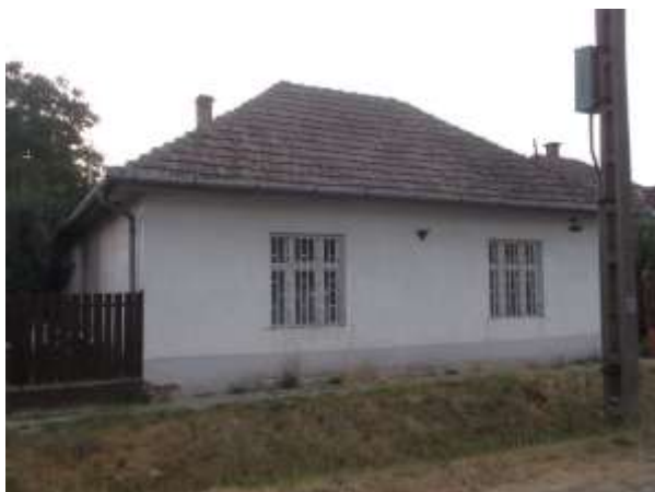
Az épület homlokzata
